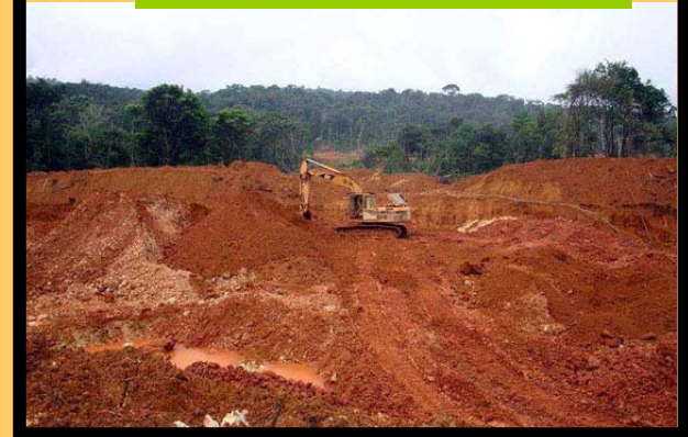
Une entreprise « exemplaire » (pour les tables à secousses)
